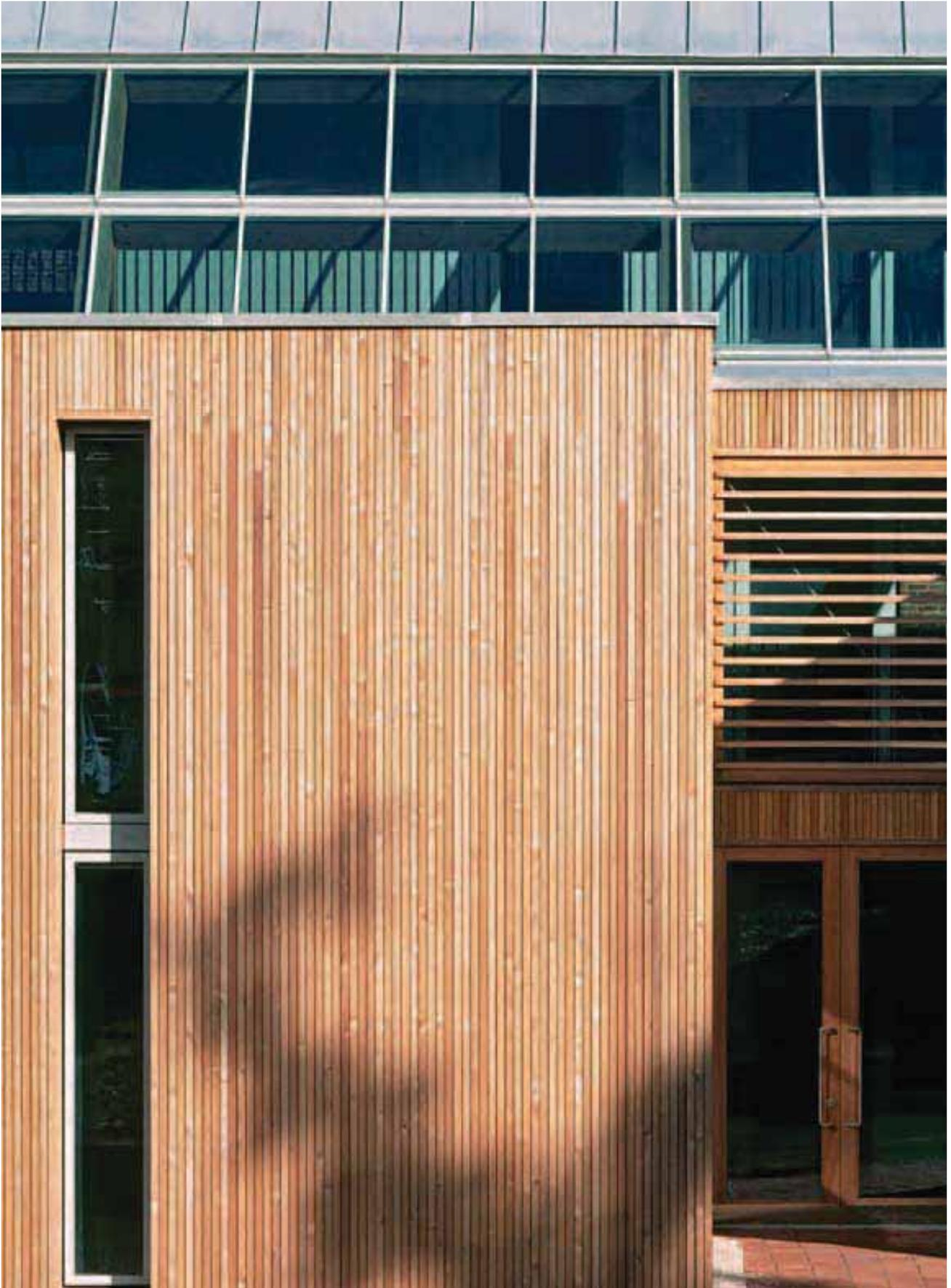
*La finitura esterna delle pareti è costituita da un curtain wall in doghe di larice montate in verticale e utilizzate anche come brise soleil orizzontale per schermare le finestre rivolte a sud*
