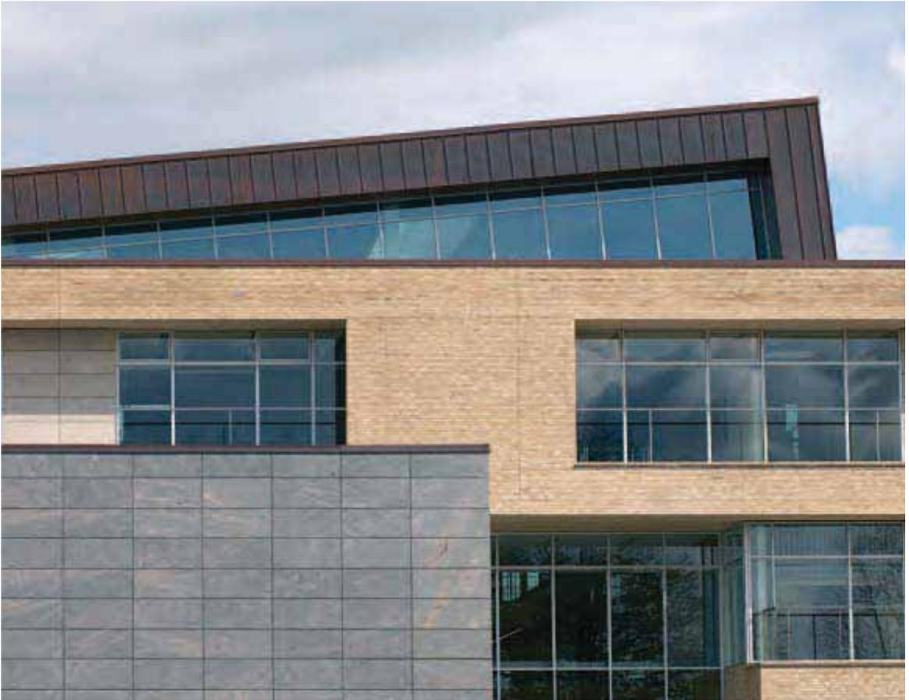
*Dettaglio dei tre elementi che compongono la scuola: il volume grigio della sala multiuso, quello in mattoni gialli delle aule e, sullo sfondo, la sagoma inclinata del corpo centrale rivestito in rame*
