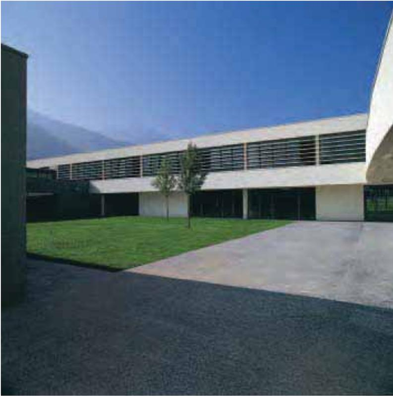
*Le finestre a nastro delle aule, schermate da brise soleil costituiti da scatolari in alluminio, possono essere oscurate internamente da tende a rullo*
