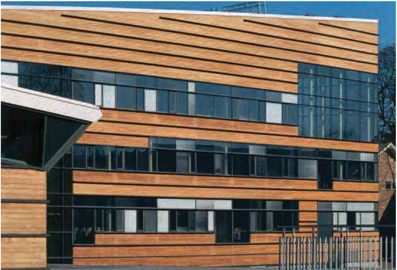
*Il trattamento degli elementi di rivestimento, sottoposti a un processo naturale alle alte temperature, conferisce al legno caratteristiche di stabilità e durezza simili a quelle dell'alluminio*
