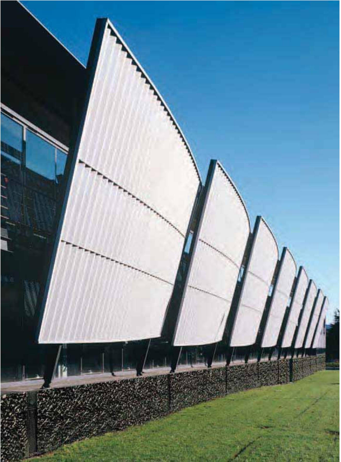
*I grandi schermi in alluminio plissettato e microforato sono fissati a una struttura metallica che poggia su uno zoccolo di cemento nero a finitura sbozzata; proteggono gli ambienti interni dall'irraggiamento solare e dal rumore della strada*
