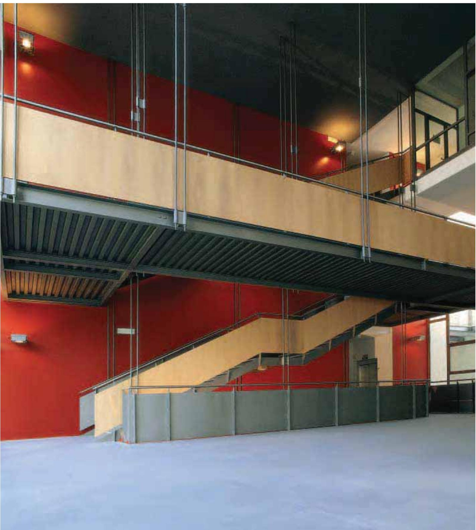
*Nel grande vuoto dell'atrio campeggia la scala sospesa al soffitto da coppie di tiranti di acciaio; la struttura metallica è verniciata in grigio scuro e contrasta con i parapetti in legno e con la parete di fondo*
