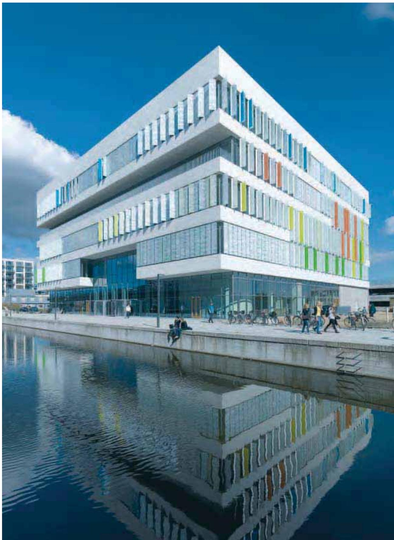
*La scuola si rispecchia nel canale artificiale che fiancheggia l'Ørestad Boulevard; le fasce strutturali e il rivestimento in pannelli di vetro si interrompono in corrispondenza degli ambienti interni a doppia e tripla altezza*
