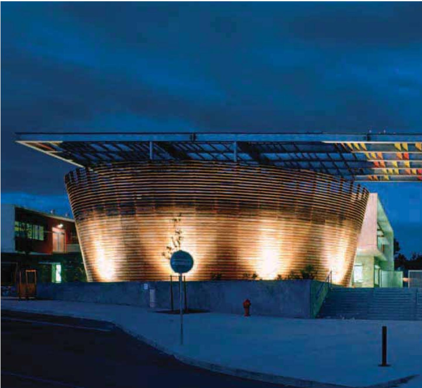
*L'accesso è sottolineato da un grande brise soleil colorato, costituito da un telaio in acciaio galvanizzato poggiato sul volume della didattica e sul cono rovesciato dell'auditorium*
