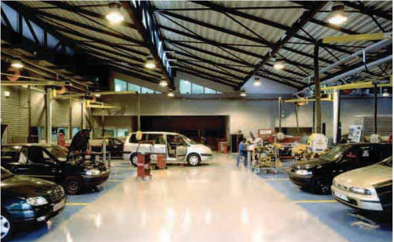
Le officine di carrozzeria e di meccanica sono illuminate dagli shed di copertura. Il trattamento e le finiture interne ricordano gli ambienti industriali: la struttura e gli impianti sono a vista, le pareti sono rivestite di pannelli di alluminio, il pavimento è caratterizzato dalle segnature colorate che individuano gli stalli dei veicoli da riparare
